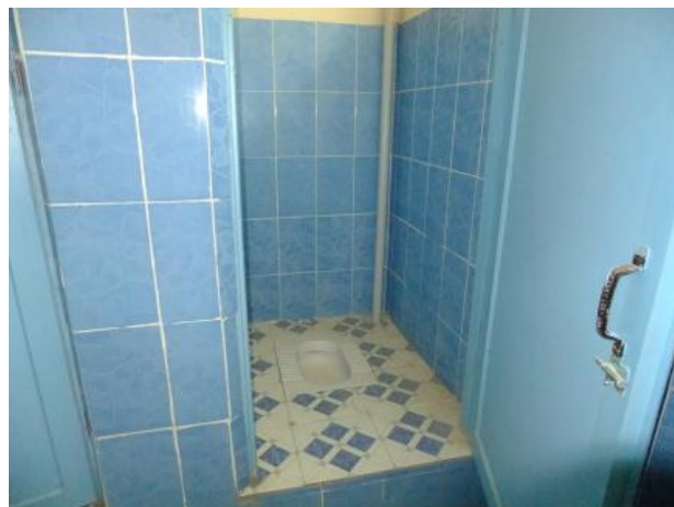
С новыми отремонтированными туалетами, гигиена окружающей среды данной школы значительно улучшилась
