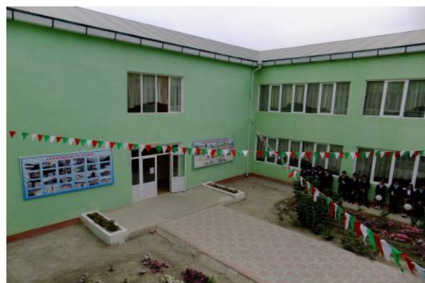
Здания отремонтированной школы. Справа и слева на стене школьного здания фотографии, представляющие школьного здания до и после реализации проекта
